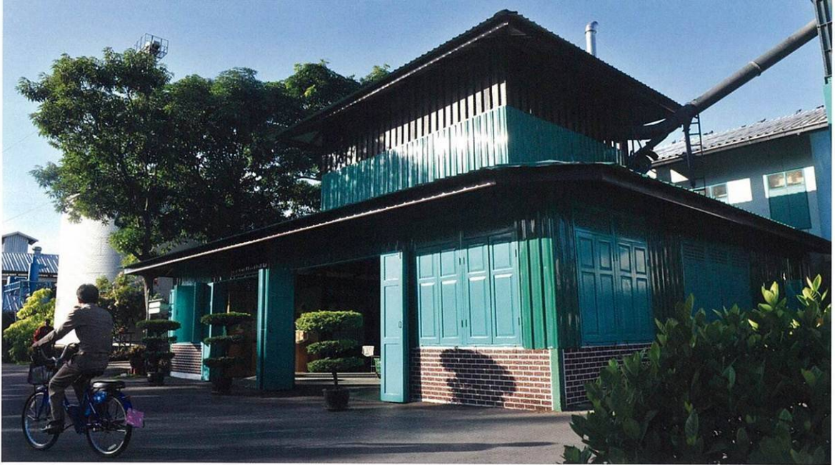
โรงบดแกลบภายในโครงการส่วนพระองค์ สวนจิตรลดา
